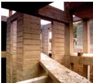
竹溪居A3天井套天井
