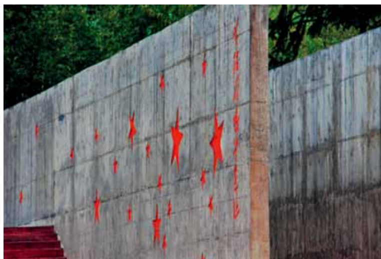
糙面混凝土墙体
