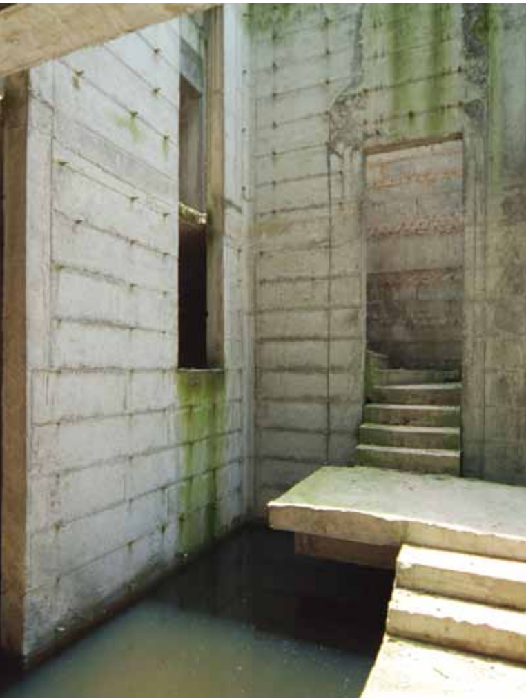
竹溪居A11入口水院
