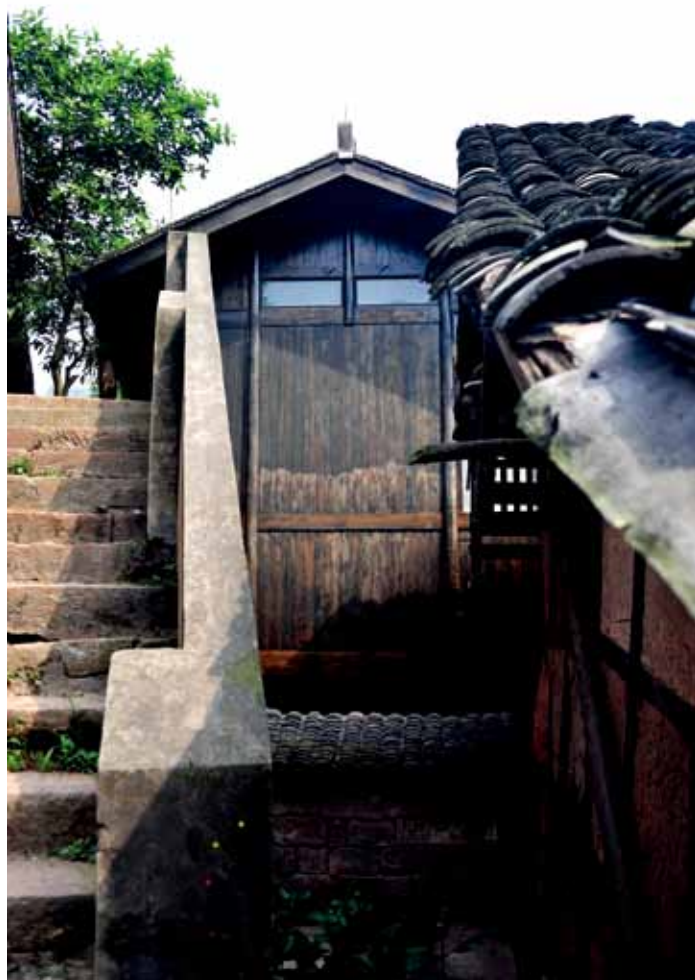
西北側立面局部
